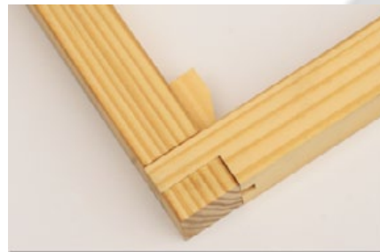
Las cuñas se colocan con facilidad empujandolas manualmente y golpeando posteriormente con el martillo.
