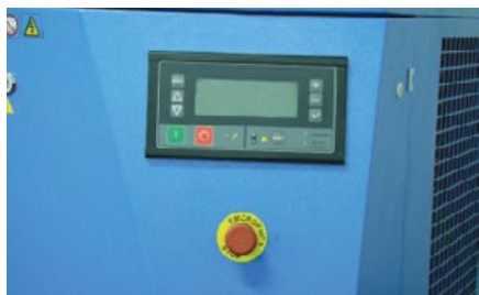
Panel de mandos situado en el frontal del armario metálico.
